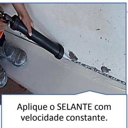
Corte o bico do aplicador com no diâmetro próximo a largura da junta. Aplique com pouco excesso evitando desperdício ao dar acabamento.
