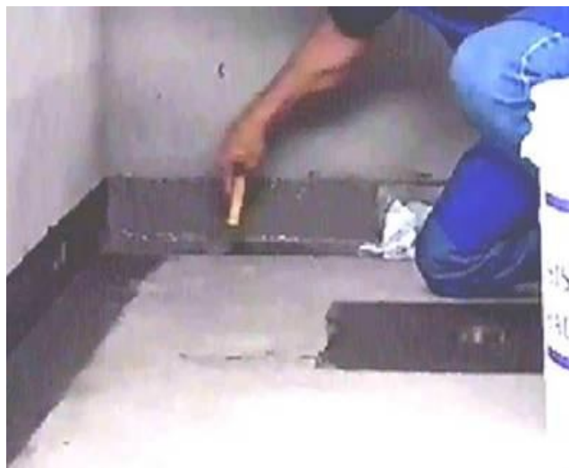
Aplicação da Bautela AR 20 nos Rodapés
