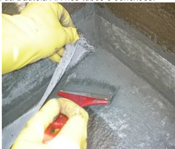
Aplicação da Bautela AR nas conexões e Cantos
