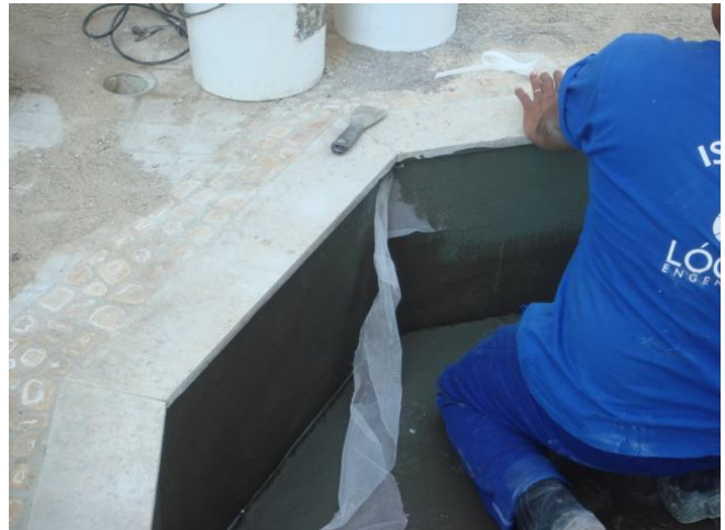
Aplicação da Bautela AR no beiral
