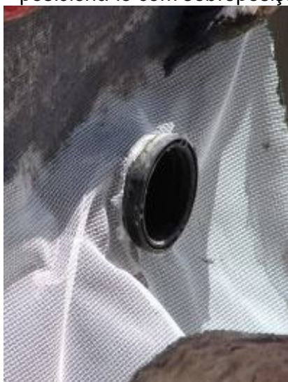
Aplicação da Bautela AR nas conexões e Cantos
