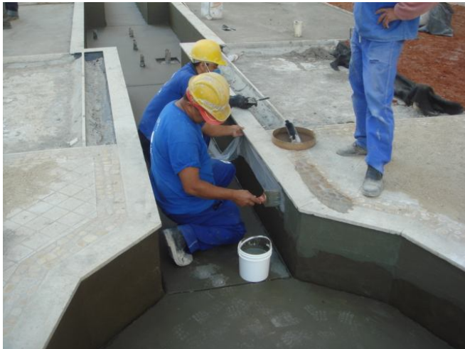
Aplicação da Bautela AR no beiral
