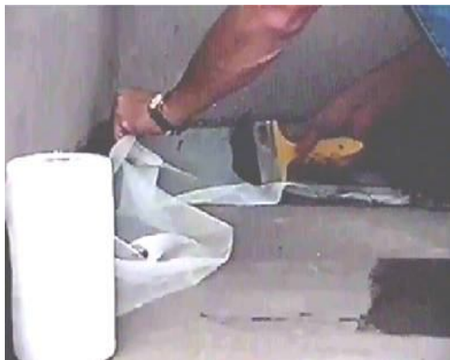
Aplicação da Bautela AR 20 nos Rodapés
