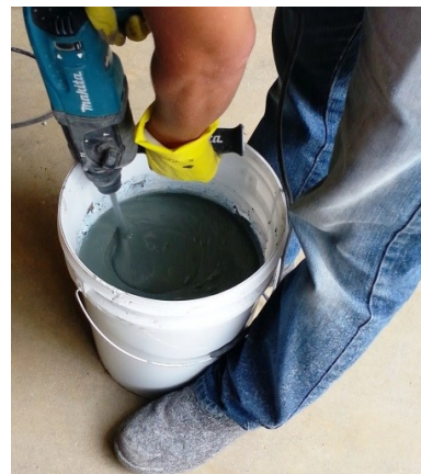
MAI – Mistura com batedor acoplado a furadeira
