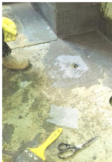
Imagem 5 – Aplicação da MAI com Estruturante no rodapé, ralo e passante
