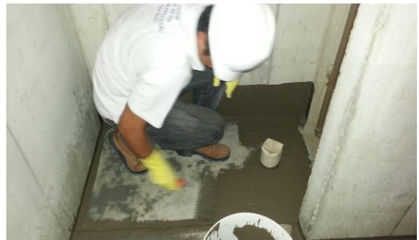
Imagem 4 – Aplicação da MAI sem Estruturante
