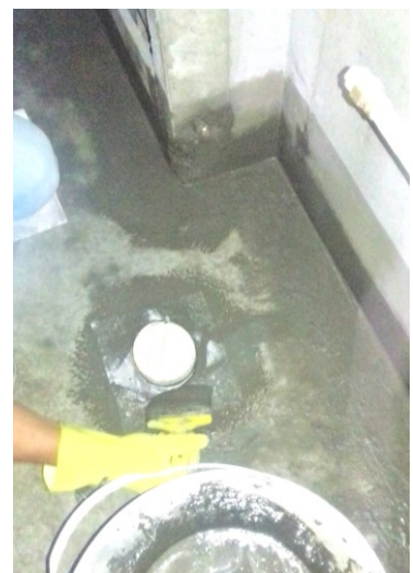
Imagem 5 – Aplicação da MAI com Estruturante no rodapé, ralo e passante
