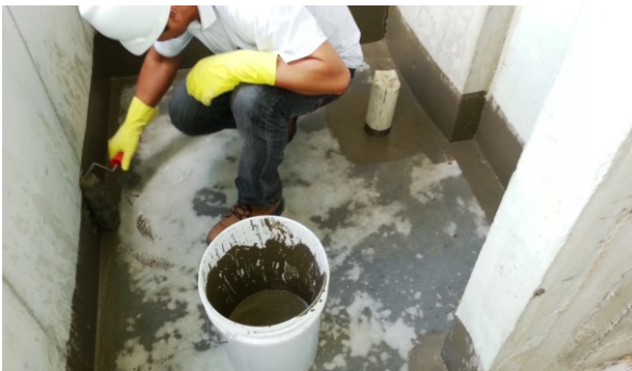
Imagem 4 – Aplicação da MAI sem Estruturante
