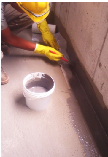
Imagem 5 – Aplicação da MAI com Estruturante no rodapé, ralo e passante
